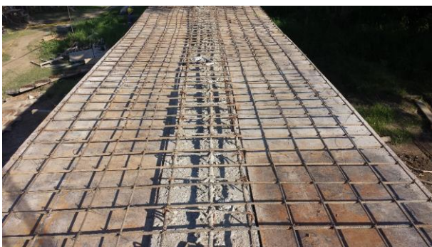
Foto 1: Refuerzo para viga placa tramo 4
