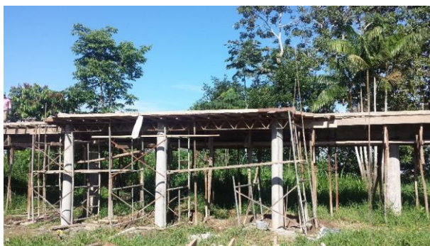
Foto 2: Formaleta para balcón en el tramo 4
