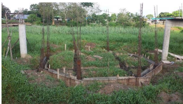
Foto 9: Refuerzo viga de cimentación mirador N° 1 - K0 + 170
